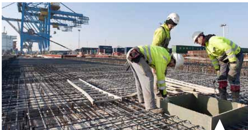
Albert II quay wall, Zeebrugge, Belgium
